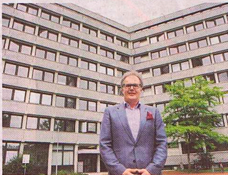
Amtsvorsteher Andreas Romeiser vor der maroden Fassade
